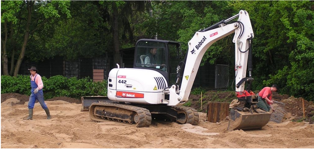
Schweres Gerät im Einsatz
